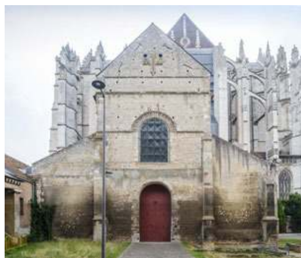
Notre-Dame de la Basse-Cœuvre © Fernanda Sánchez-Paredes pour la DRAC Hauts-de-France
