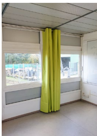
Installation de rideaux anti-feu dans la salle multifonction
